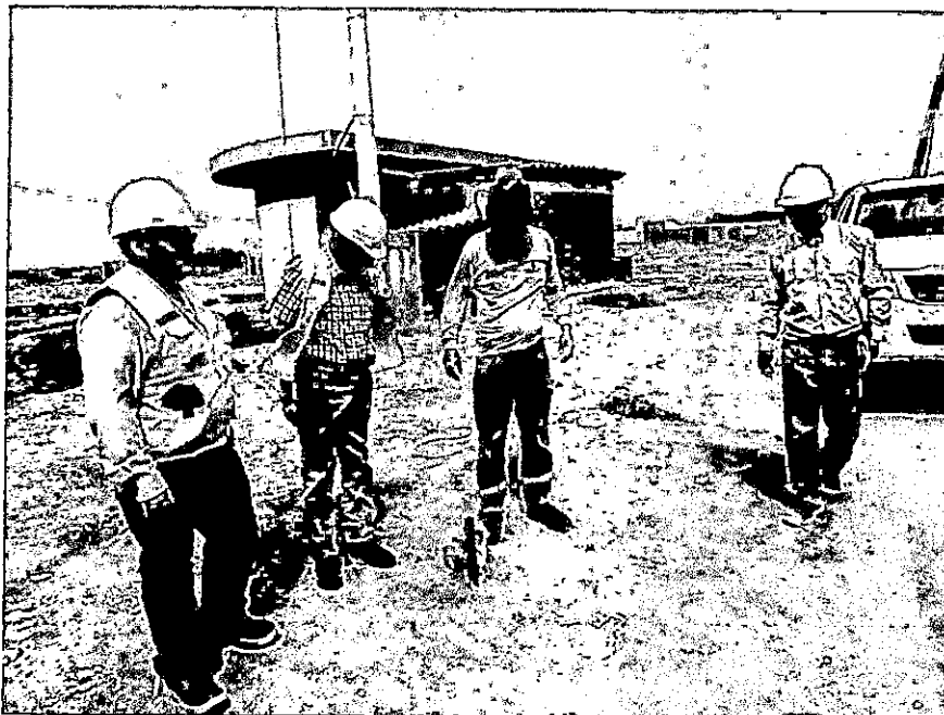
OTRA VISTA DEL REPLANTEO DE CABLES AEREOS Y SUBTERRANEOS CORRESPONDIENTES AL ADICIONAL N° 10
