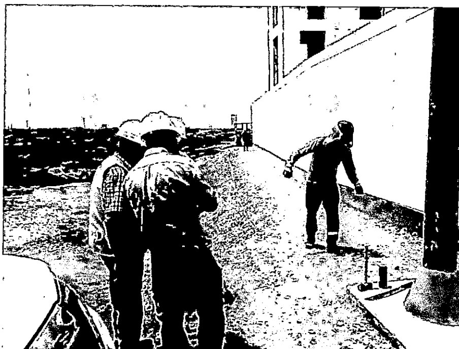
SUPERVISOR, RESIDENTE Y PERSONAL ENCARGADO DEL ADICIONAL 10, EN TRABAJOS DE REPLANTEO
